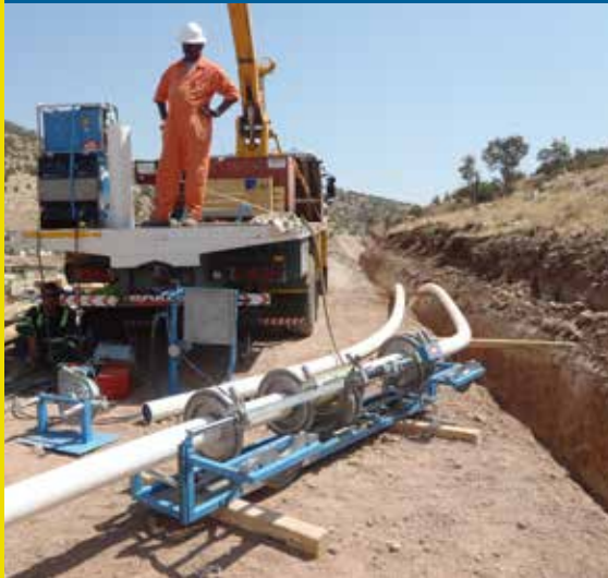
Equipo de single swage (prensado simple)
